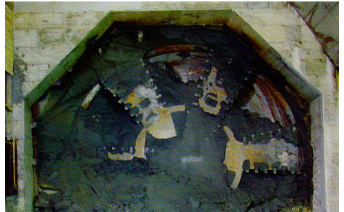
Figure 10: sauberes Schneidrad nach Durchbruch
