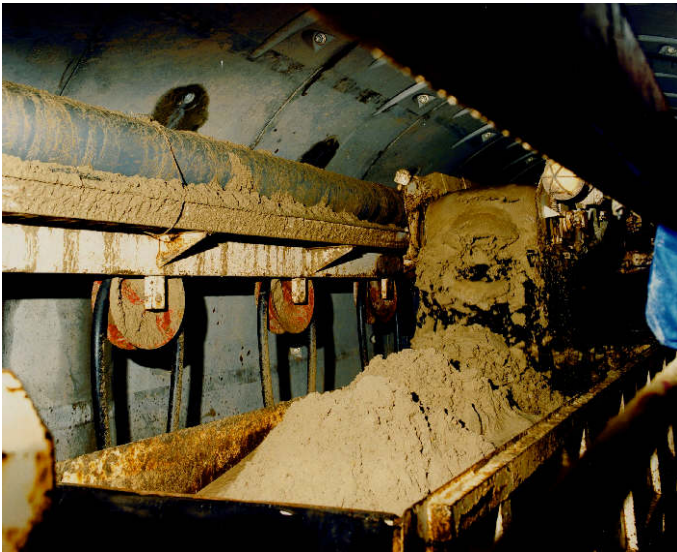
Figure 9: Aviles Vortrieb mit Schaum & Polymer
