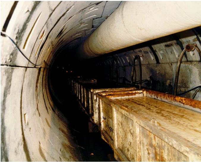
Figure 8: Aviles Vortrieb nur mit Schaum
