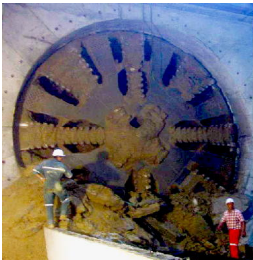
Figure 12: sauberes Schneidrad nach Durchbruch
