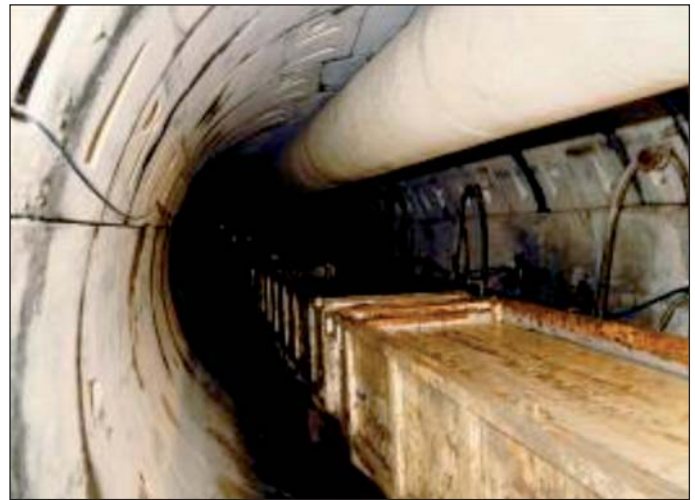
Obr. 8 Ražba v písku pouze s použitím pěny
