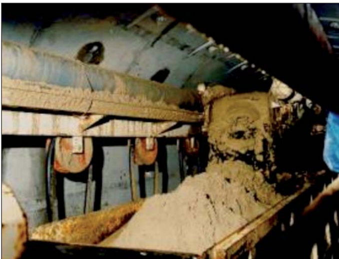
Obr. 9 Ražba v písku s pomocí pěny a polymerů
