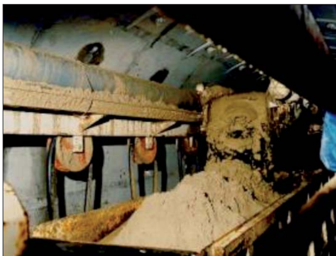
Obr. 9 Ražba v písku s pomocí pěny a polymerů Fig. 9 Sand excavation with Foam & Polymer
