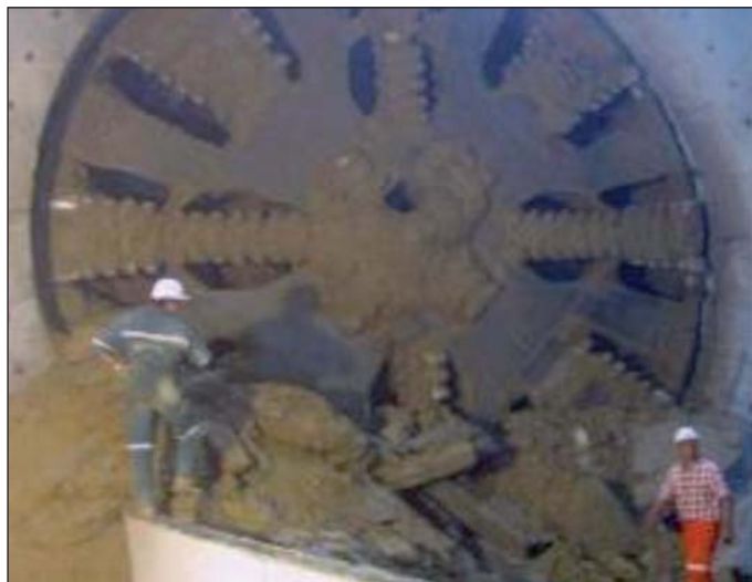
Obr. 12 Čistá řezná hlava po prorážce Fig. 12 Clean cutterhead after breakthrough
