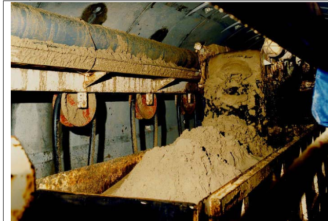
Bild 9: Aviles Vortrieb mit Schaum & strukturierendem Polymer
