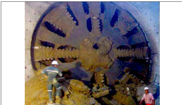
Bild 11: sauberes Schneidrad nach Durchbruch
